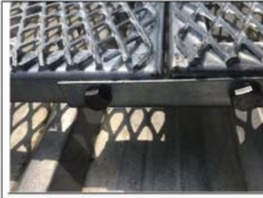
การยึดติดตั้ง ตะแกรงทางเดินโซลาร์เซลล์ XS43
