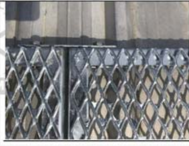
การยึดติดตั้ง ตะแกรงทางเดินโซลาร์เซลล์ XS43
